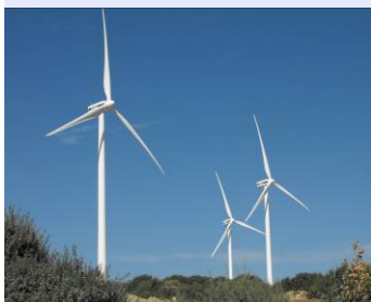
Εικόνα 11. Μεγάλες ανεμογεννήτριες (2 MW) στο αιολικό πάρκο στους Ορείτες
