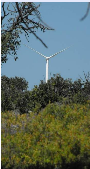
Εικόνα 12. Μεγάλη ανεμογεννήτρια (2 MW) στο αιολικό πάρκο στους Ορείτες
