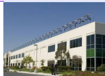
Εικόνα 15. Μικρές Ανεμογεννήτριες ενταγμένες στο αστικό περιβάλλον Πηγή: http://oregonstate.edu
